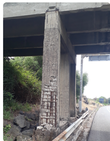
Esempio di ammaloramento di pila di cavalcavia
