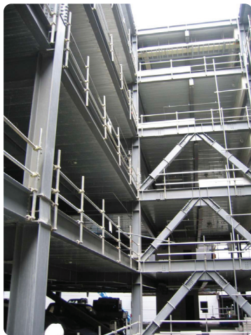
Struttura in acciaio con controventi concentrici
