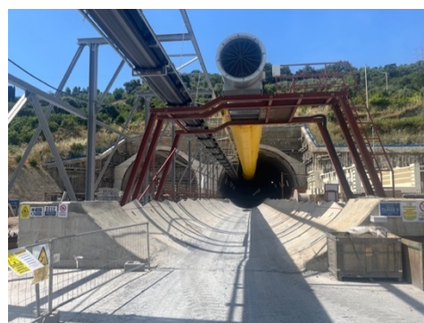
Galleria del raddoppio ferroviario Giampilieri-Fiumefreddo
